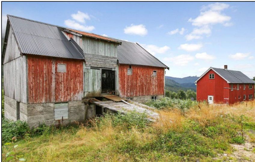
Fjøset og våningshuset sett fra nordsiden.
