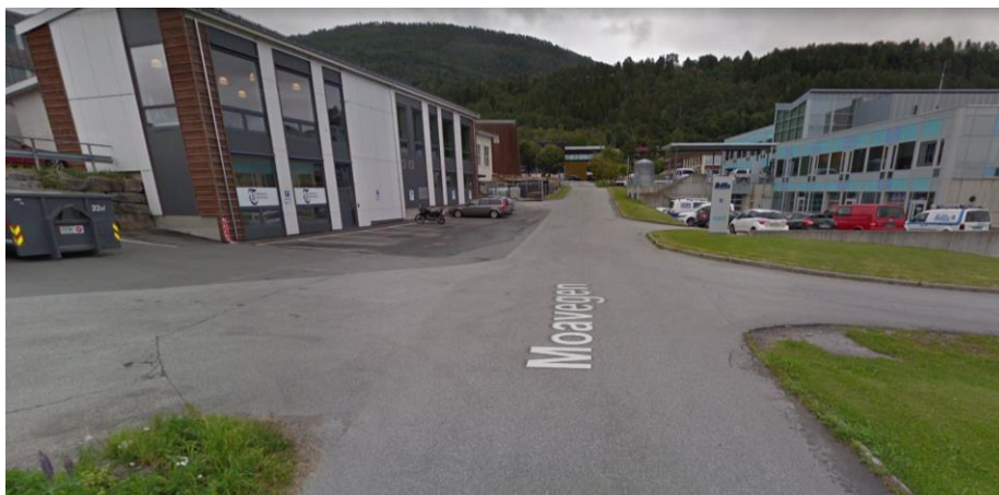
Figur 3-4: Utflytende kryss og utydelig definert vegareal langs Skeistrøvegen (feil gatenavn i google). (Kilde: google.com/maps ).
