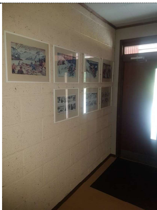
Bilde viser lecaveggen som deler «ny delen» av skolen.
