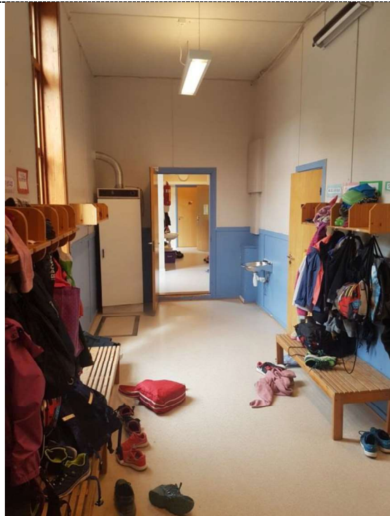
Bilde viser eksempel på lagring i rømningskorridor på skolen.
