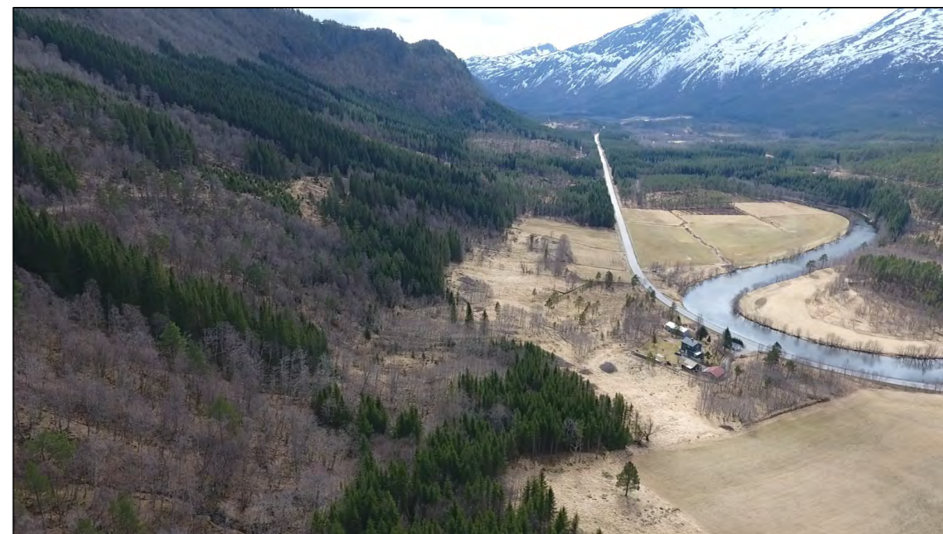
Figur 15. Oversiktsbilde mot sør (Ålvundeidet som viser området for avkøyrsløse frå rv. 70.
