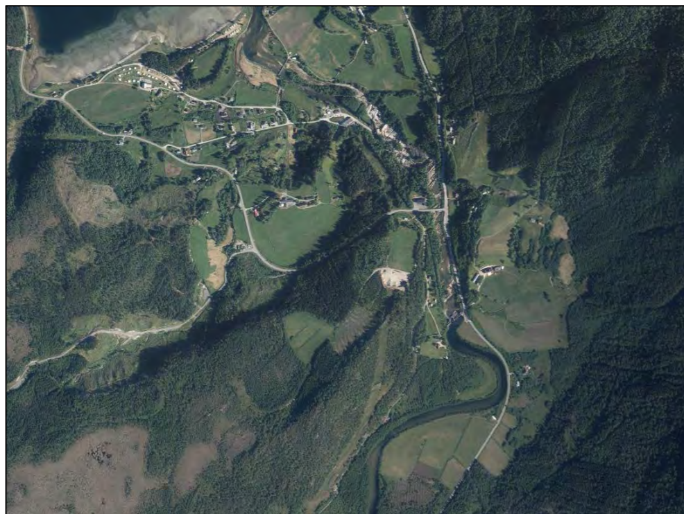
Figur 13. Flyfoto oversiktsbilde Ålvundfossen.
