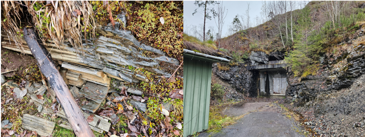
Figur 6: Bilde av antatt kvartsskifer i infopunkt P4 (foto til venstre) og fra påhuggsområdet til eksisterende høydebasseng (foto til høyre).
