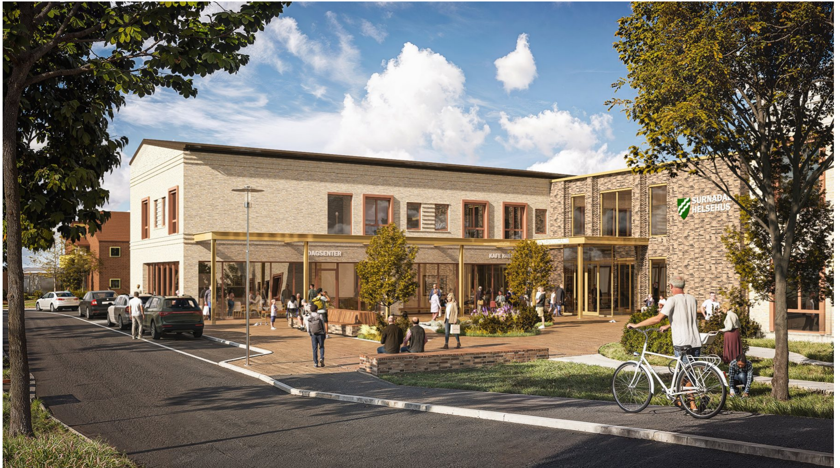
Helsehuset sett fra adkomsten i Bårdshaugvegen. Her vil det ligge utadrettede funksjoner for nabolaget.
