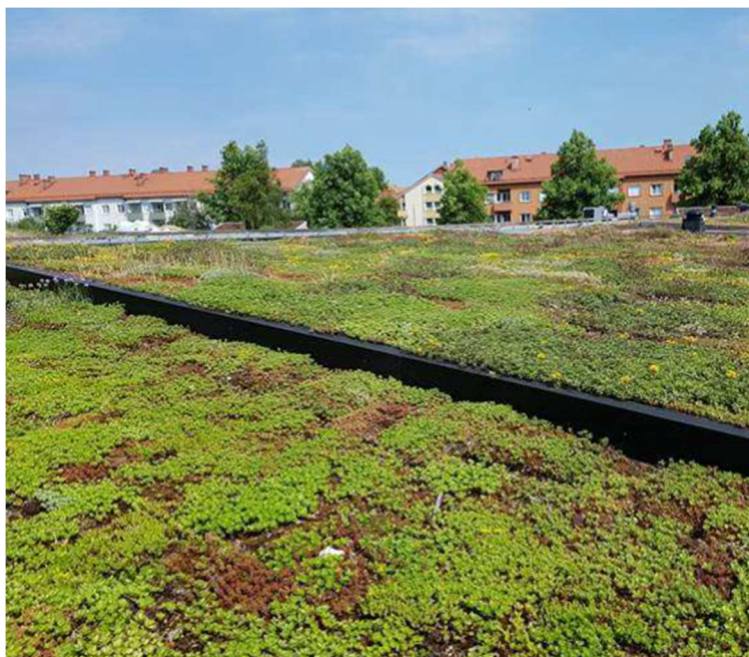
Figur 11: Grønt tak etablert på Scandinavian Green Roof Institute i Malmö, Sverige. Grønne tak kan også kombineres med fordrøyningsmagasin under jordlaget.
