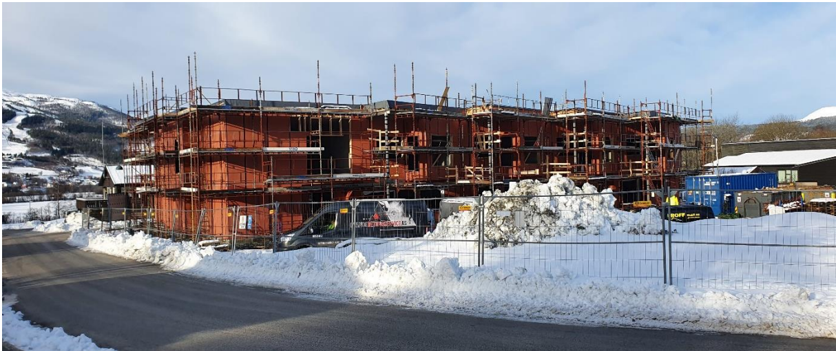
Bilde 2 Omsorgsboligar under oppføring vinteren 2021
