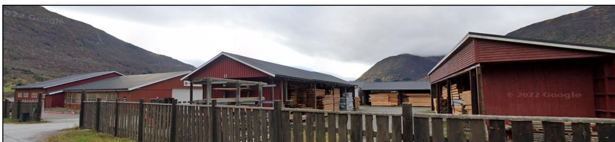
FIGUR 17 VISER FLEIRE AV BYGGA PÅ SAGBRUKET.
