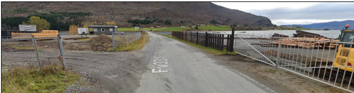
FIGUR 14 VISER EKSISTERANDE AVKØYRSLE TIL SAGBRUKET, OG INN PÅ NÆRINGSAREALET AUST FOR VEGEN.
