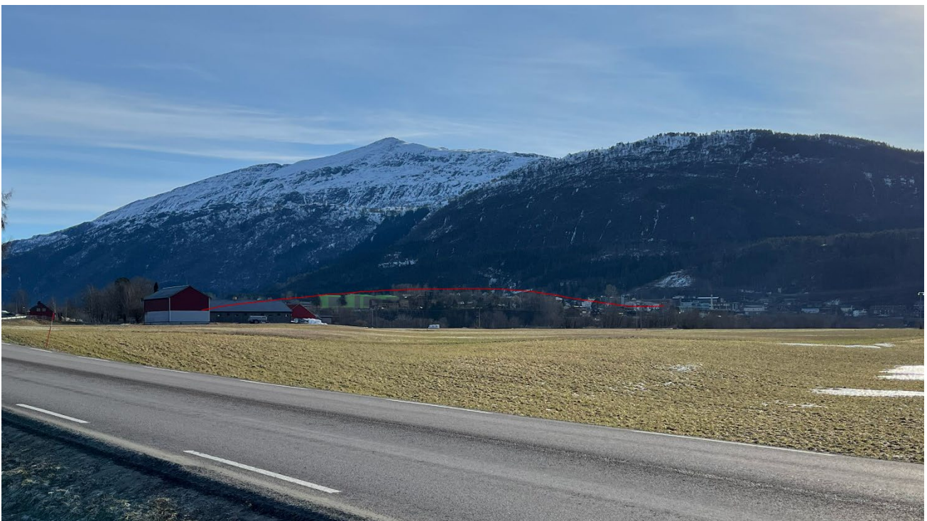
Figur 6.2.2 fjernvirkning med det nye bygget
